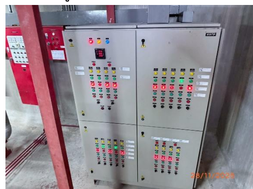
รูปที่ 9 ชุดควบคุมระบบบำบัดน้ำเสีย
