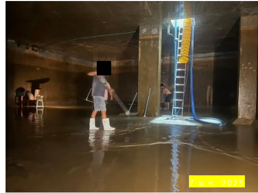
รูปที่ 21 การล้างถังเก็บน้ำสำรอง
