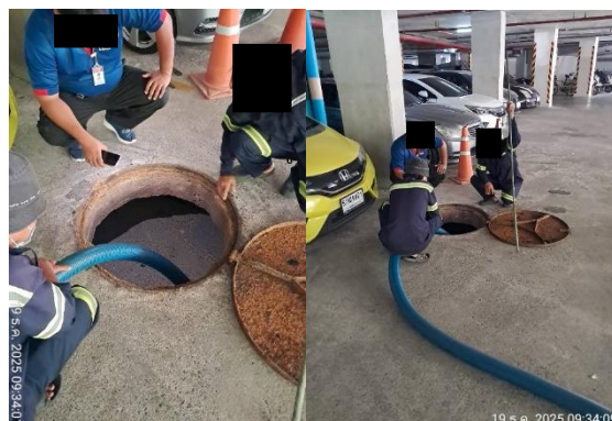
รูปที่ 39 การดักไขมันจากปอดักไขมัน
